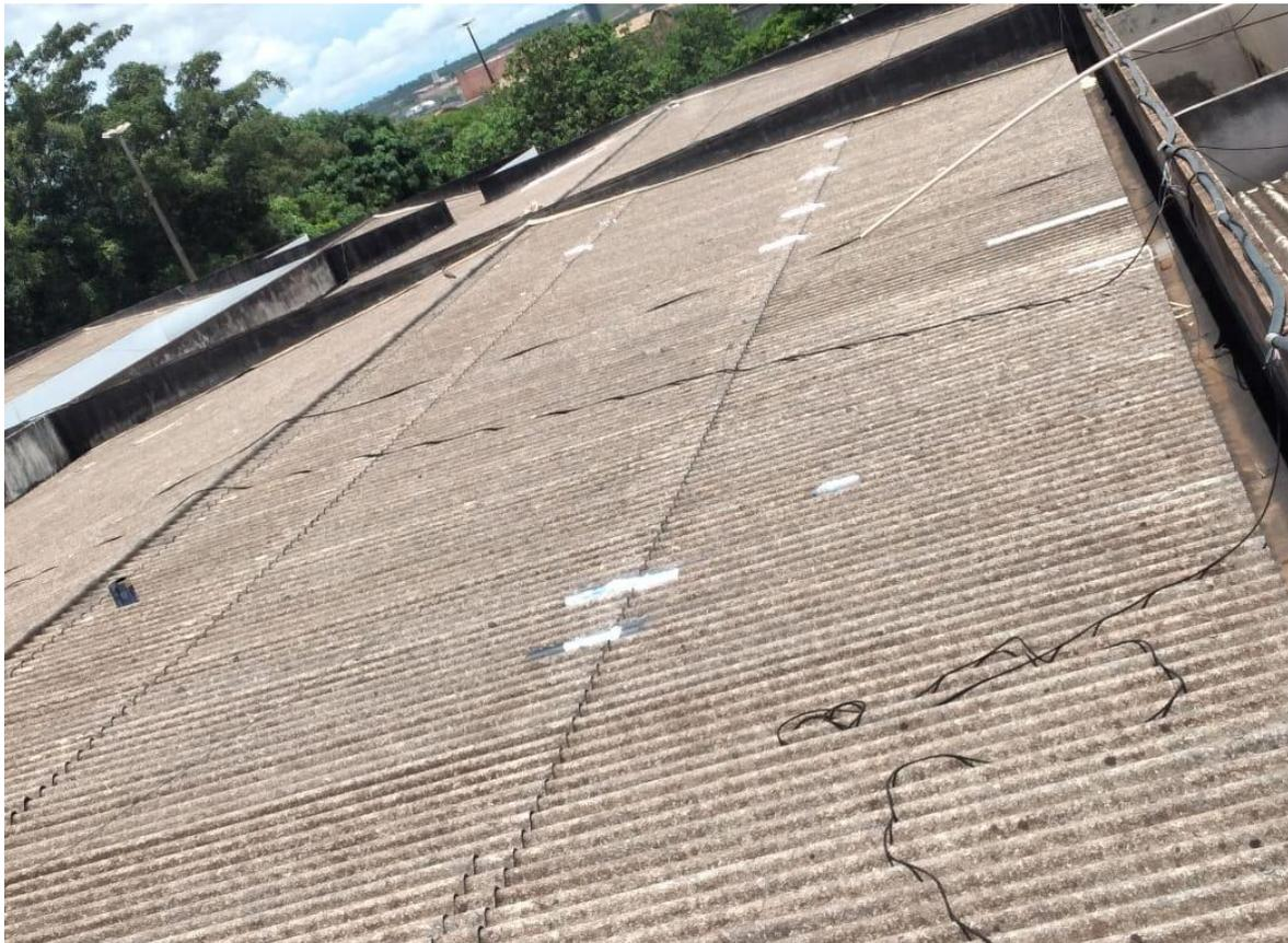
Após as primeiras chuvas foi feito o mapeamento de infiltrações e o devido tratamento com manta asfáltica aluminizada.
