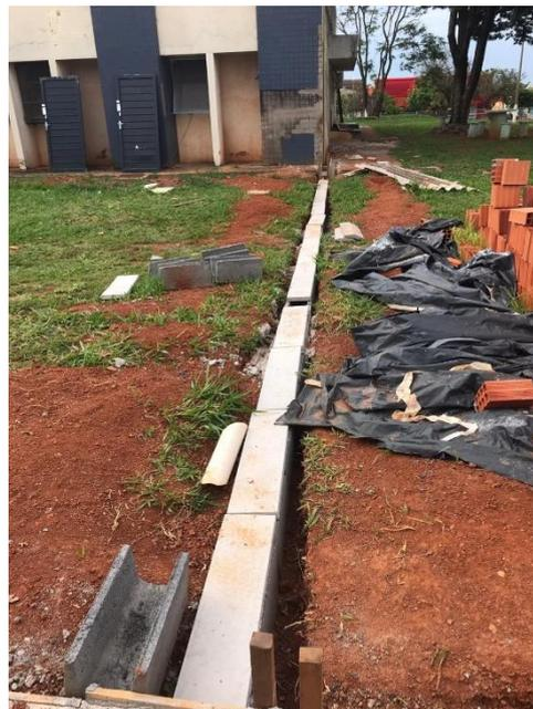
Instalação de canaleta em concreto com tampa para a passagem de tubulação de gases medicinais.
