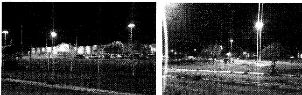
Foto 01 : Início do reparo e substituição de postes de iluminação externa.
