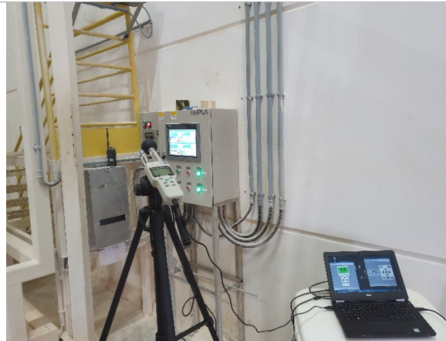
Foto 1 – Medição de Ruído e Calor.
