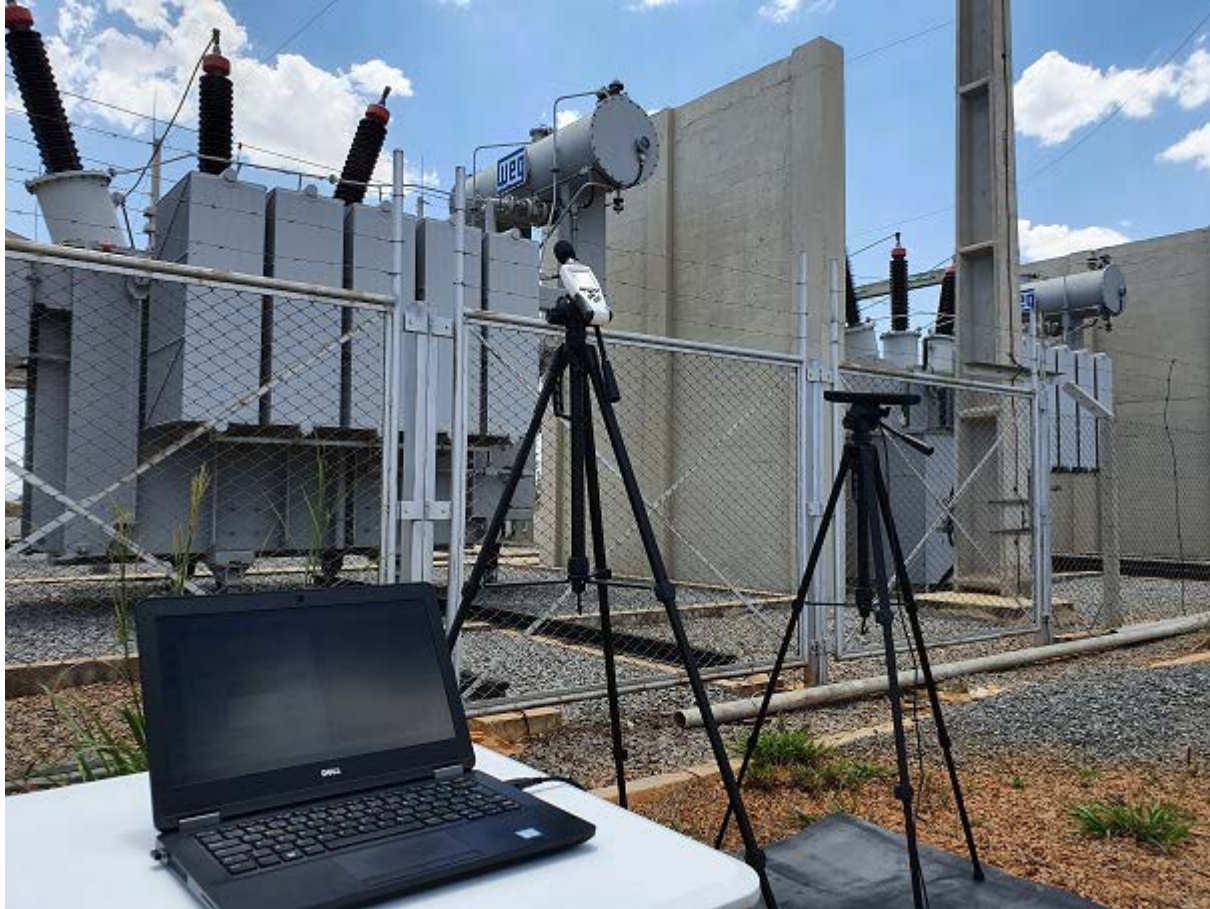
Figura 2 – Demonstrativo de medições realizadas em campo
