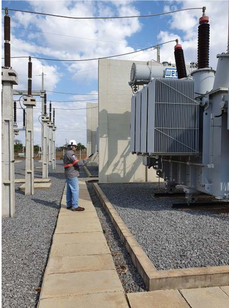
Figura 11 - Demonstrativo de medições realizadas em campo
