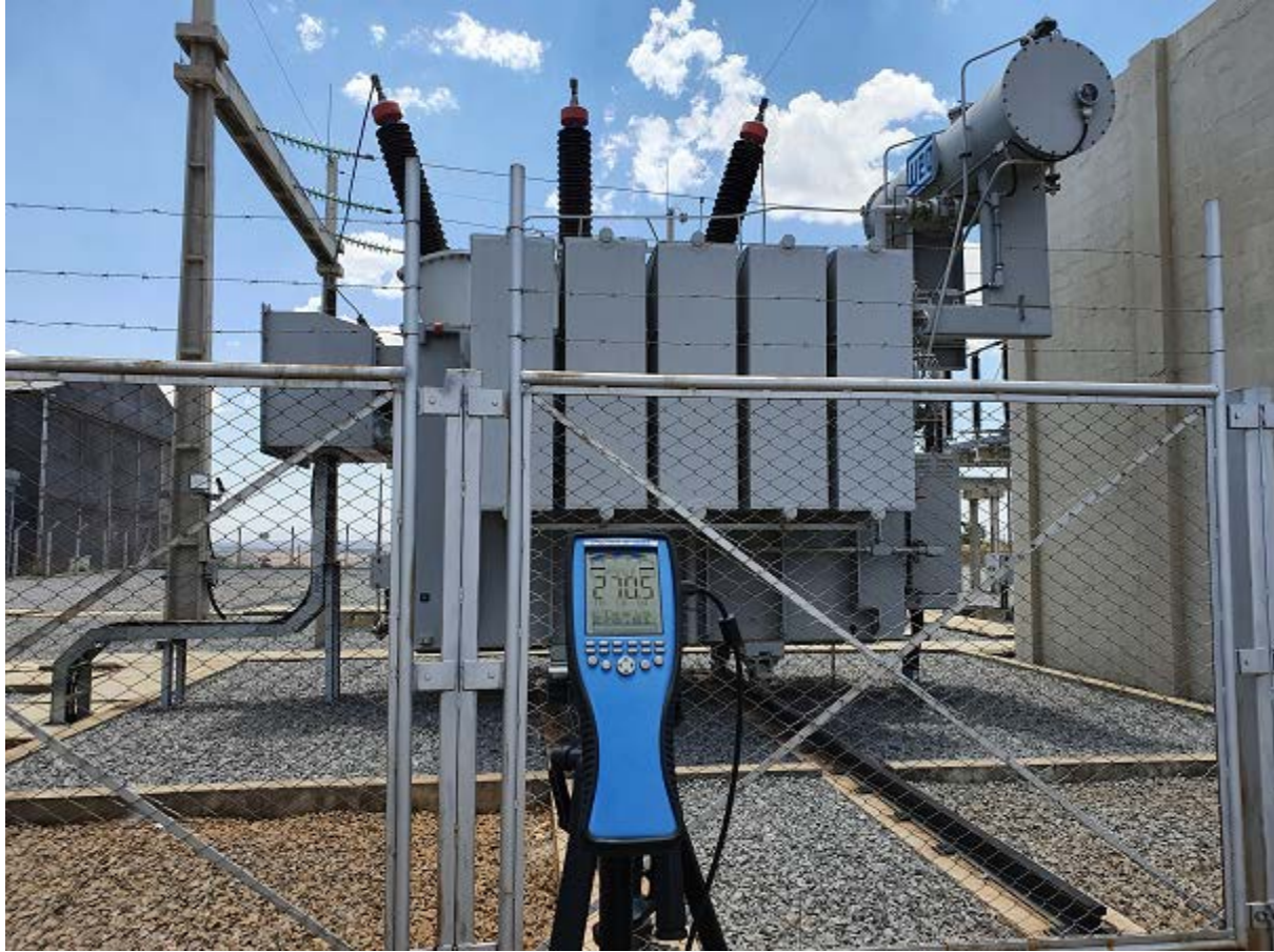
Figura 3 - Demonstrativo de medições realizadas em campo
